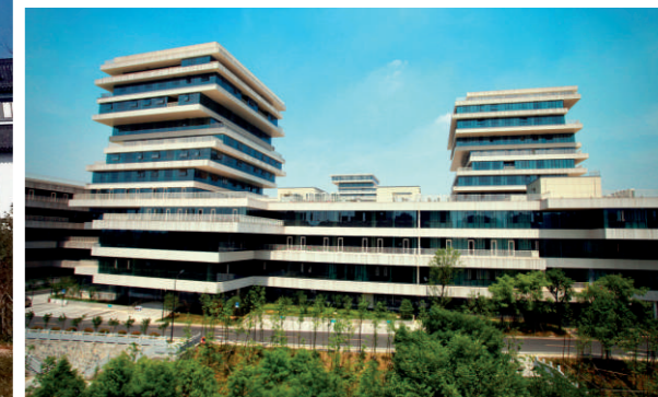
杭州师范大学仓前校区一期工程中心区西块工程
