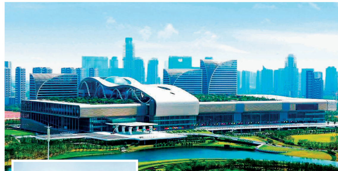
杭州国际博览中心（G20杭州峰会主会场）
