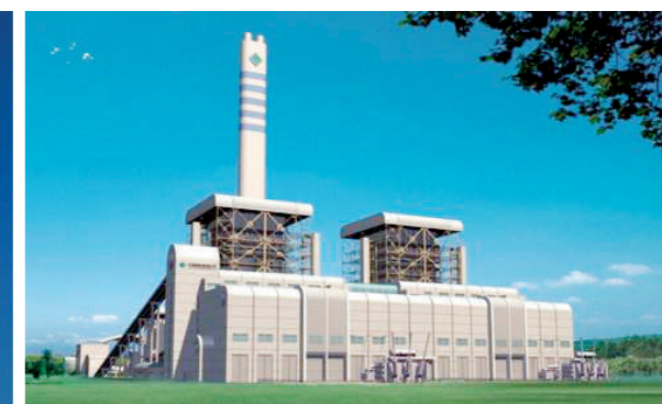
浙江台州第二发电厂2×1000MW新建工程
